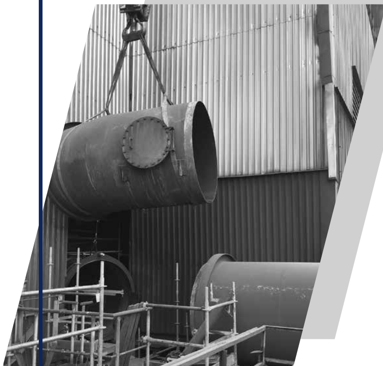
Výmena časti potrubia na DZ Oceliareň
