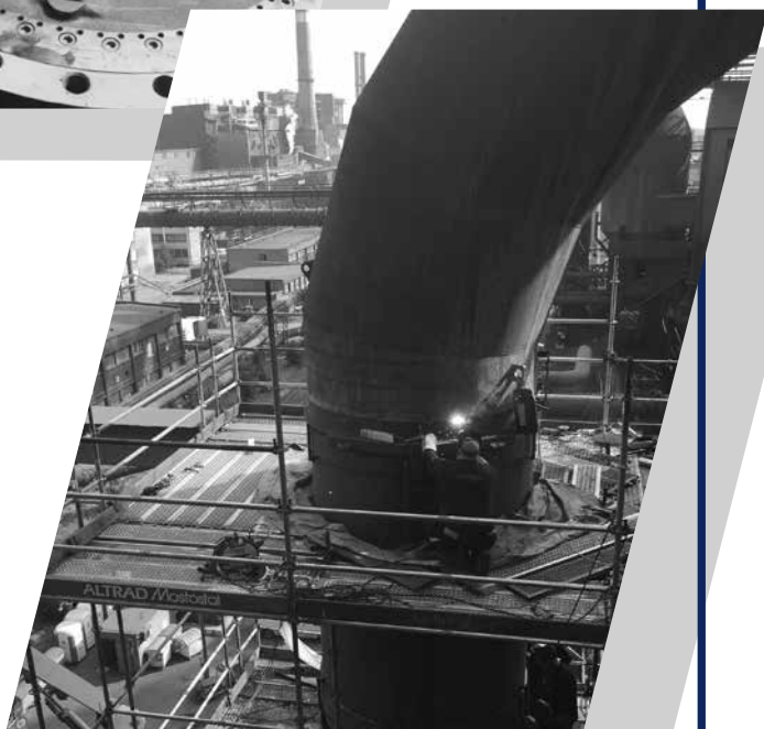
Výměna kompenzátora DN2400 na DZ Vysoké pece č.2
